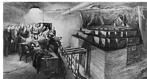
圖三. 費米在 1942 年在美国芝加哥建造第一座核子反應堆 CP-1 成功的達到核子臨界, 證明了原子能發電的可行性. (圖像取自歷史檔案)
